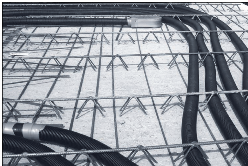
Neubau - Verlegung in der Betondecke
