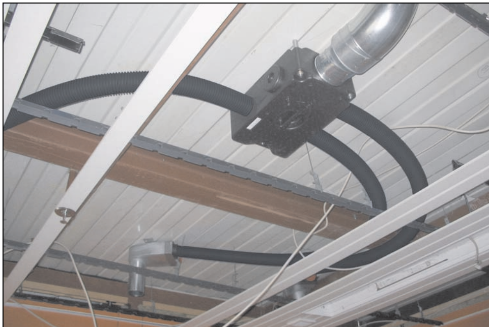
Sanierung - Verlegung in abgehängter Decke*
