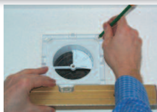
AZE ausrichten und anzeichnen
