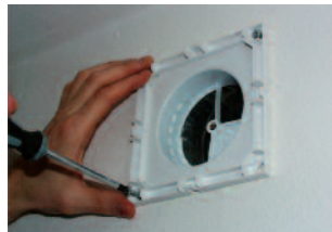
AZE befestigen – mind. 2 Schrauben
