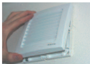
Abdeckung befestigen
