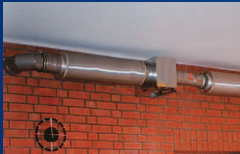
Die Box-Ventilatoren sorgen in den Klassenzimmern permanent für frische Luft
