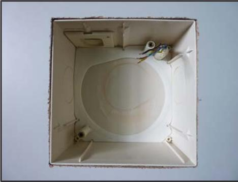
3. Insérez le joint d'étanchéité fourni au fond du boîtier. Respectez les arêtes de guidage du joint d'étanchéité.
